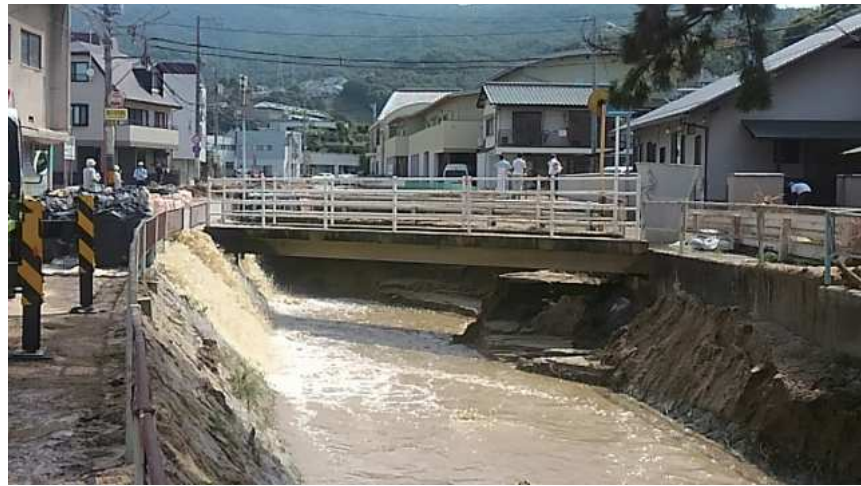
（土砂と流木で橋が閉塞した寺山橋。ポンプでくみ上げて下流に流している。7月11日撮影）
