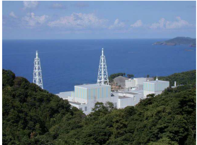
中国電力島根原子力発電所
