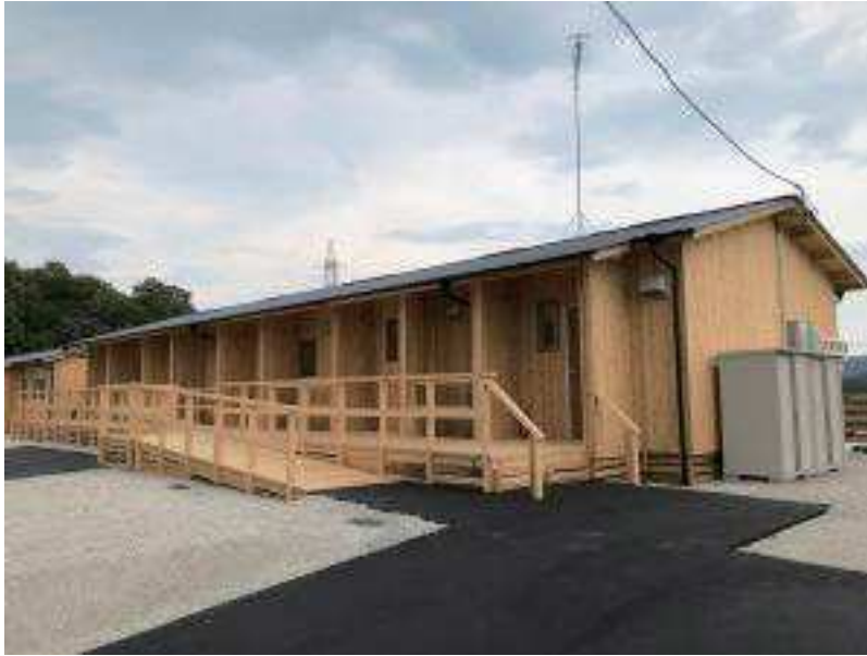
三原市沼田西町あやめが丘団地内の応急仮設住宅
