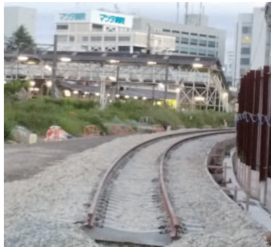
仮線工事が進む JR 山陽本線
